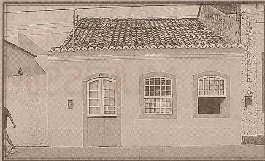
Arquitetura luso-brasileira, com vergas em arco abatido e beiral com cimalha. Tipologia adotada até fins do século XIX. Localizada na Praça República Juliana.
